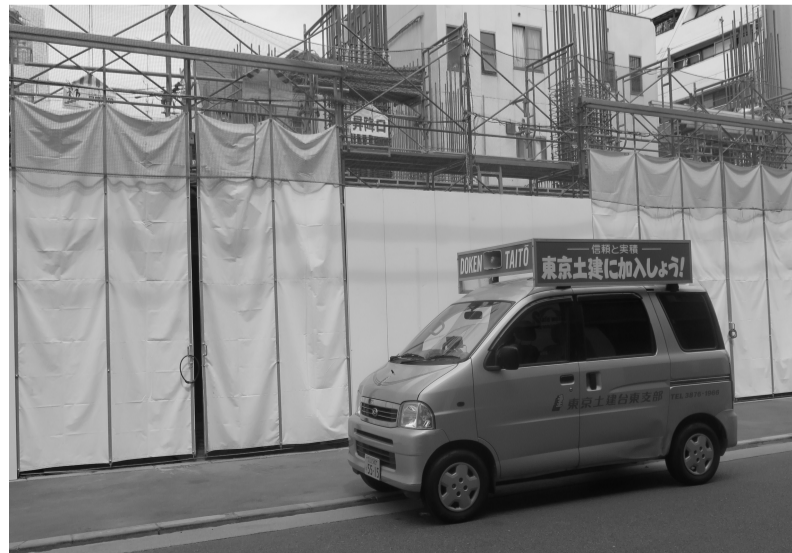
建設現場周辺で訴える宣伝カー
