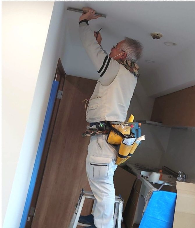
クロスの貼り替え作業中の藤田さん
